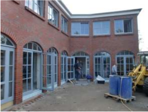
Die letzten Fenster werden montiert
